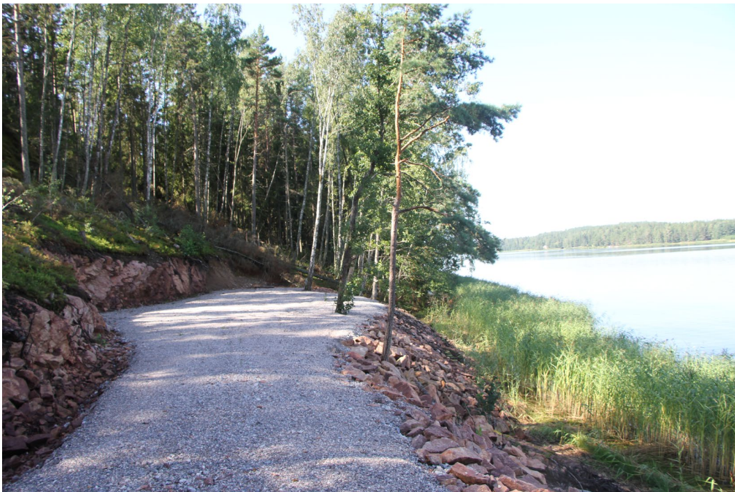
Alueen rantaan on rakennettu pengerreretty tie
