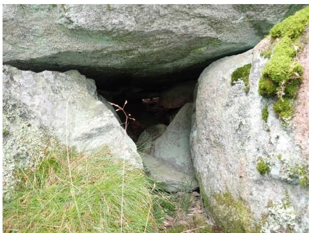
Kuva 34. Yksityiskohtakuva siltarakenteen "rum-musta". Kuvattu lounaaseen.
