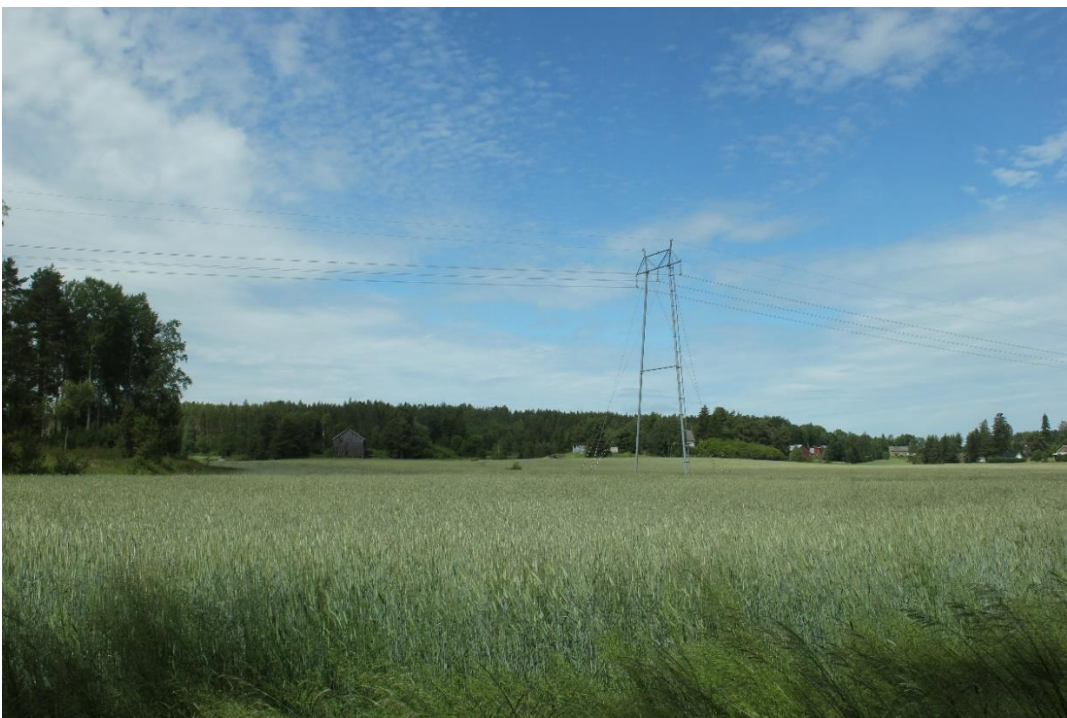
Kuva 16. Voimajohto Makilan maisemassa.
